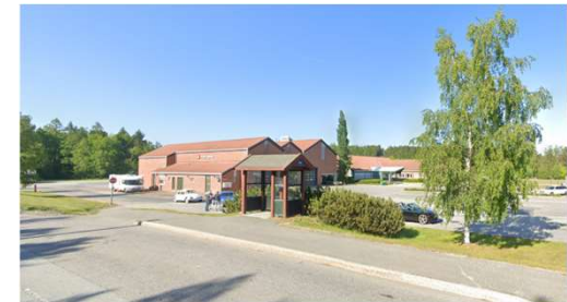
Arendal Stoa Trafikk- / kontrollstasjon
