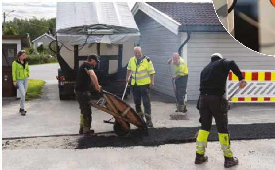
NY ASFALT: Håndlegging av asfalt
