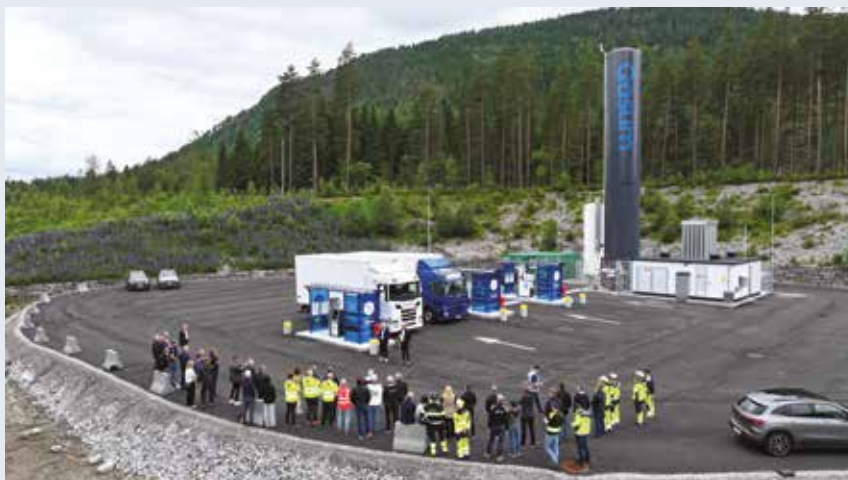
FØRDE: Biogass fyllestasjonen som ble åpen i Førde i juni ligner på den som planlegges i Kongsberg
